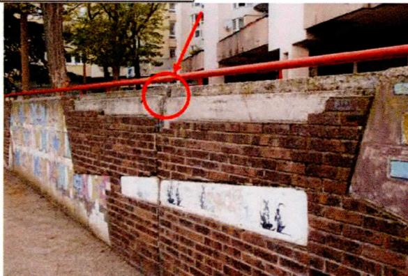
1- décrochement entre le mur central et le mur Ouest vu depuis la rampe
