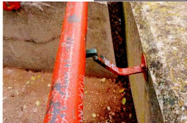
2- fixation de la lisse métallique à réparer
