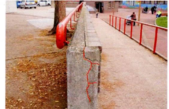
3-extrémité Ouest du mur principal : béton fissuré
